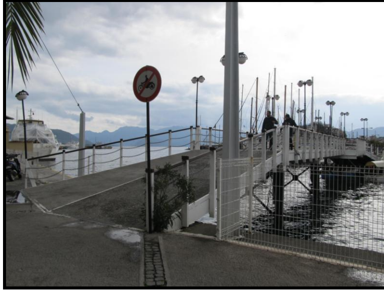
Şekil 3.14.a. Yat Limanı – Marmaris Kıyı Bandı Bağlantı Köprüsü
